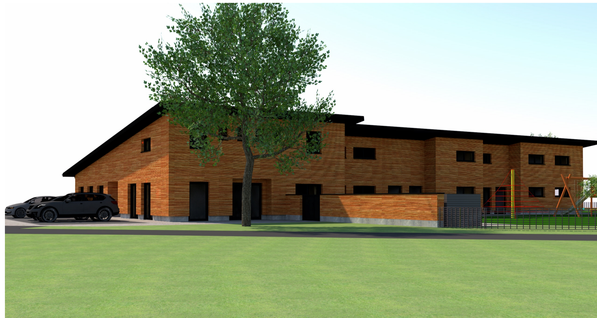
Gebäudeansicht Nord (teilweise Ost)
